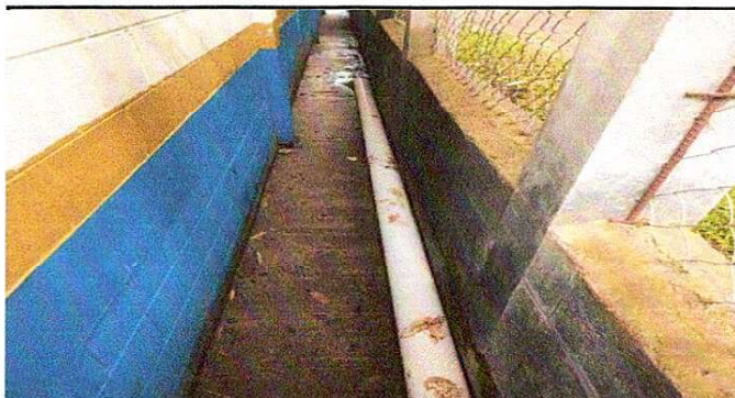
Foto 4: INSTALACIÓN DE TUBERÍA PARA DRENAJE
