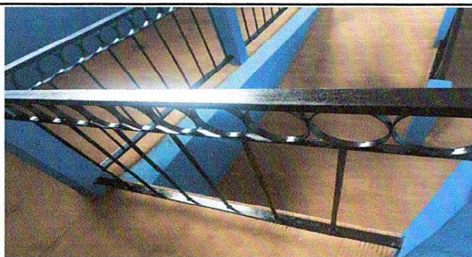
Foto 3: REMOZAMIENTO DE BARANDALES
