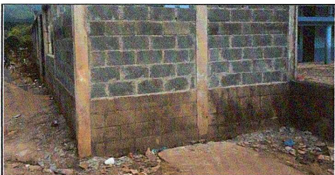
Foto 5: SUSTITUCIÓN DE ÁREA DE COCINA
