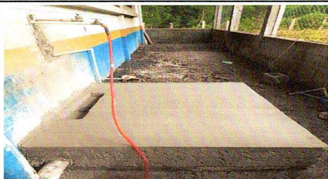
Foto 1: REPARACIÓN DE BASE DE CONCRETO PARA PILA
