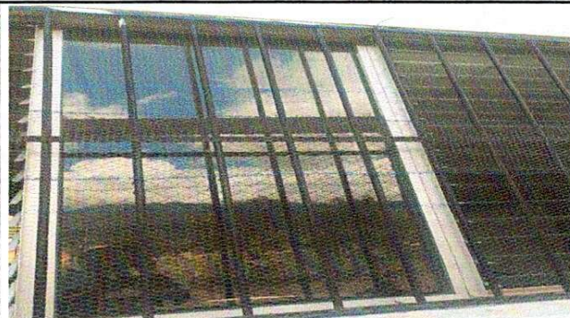
Foto 2: SUSTITUCIÓN DE VIDRIOS
