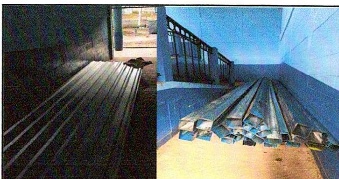
Foto 6: CAMBIO DE ENTECHADO.
